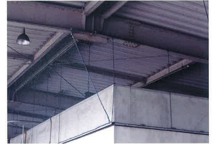
倉庫内事務所 天井部
