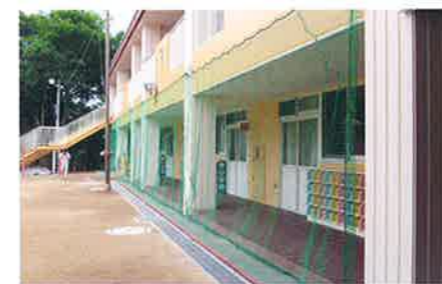
福祉施設 (ベランダ・屋外廊下)
