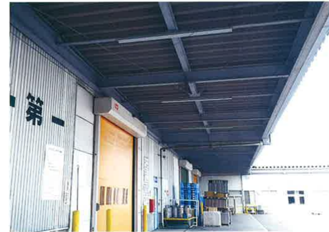
トラックヤード ひさし部
