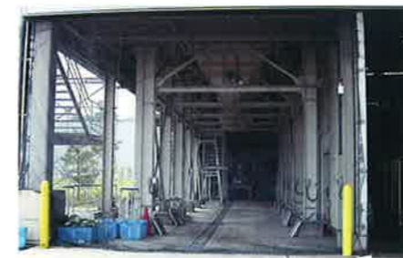
製造工場 開口部
